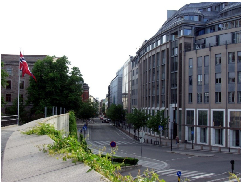
Akersgata 59 (R5), KRDs nåværende adresse. KRD har lokaler i 7. og 8. etasje. Foto: J. P. Fagerback.
